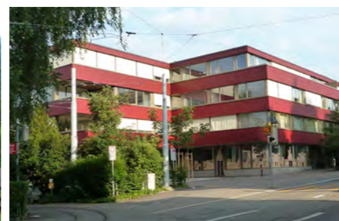
Albisstrasse wird (langsam) urbanisiert
