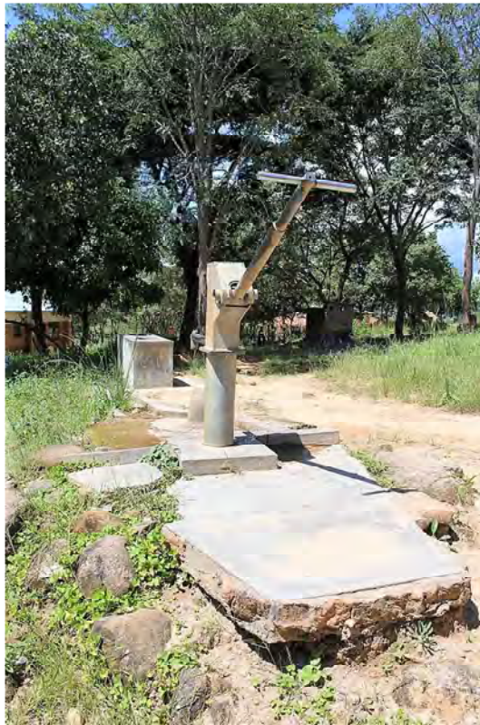
Der alte Brunnen konnte wieder in Betrieb genommen werden
