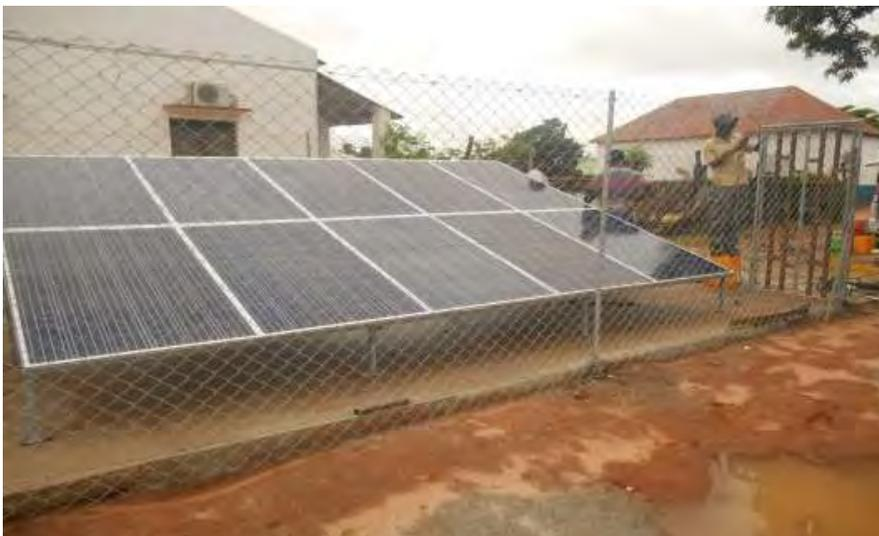
....zudem wurden Solarpanele und neue Wasserpumpen installiert, welche sowohl mit normalem wie auch mit Solarstrom betrieben werden können. Somit gibt es auch bei Stromausfall, was zur Normalität gehört, fließendes Wasser.
