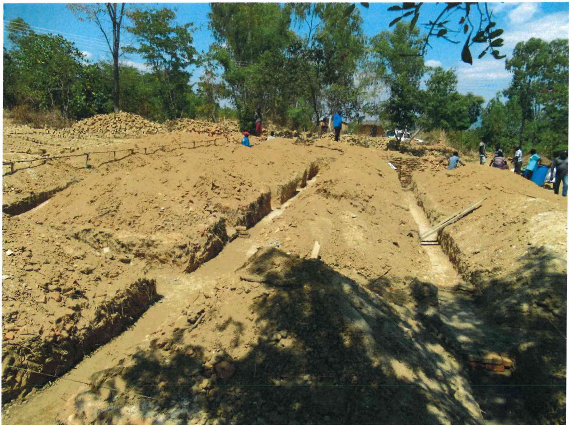
Die Gräben für die Mauern des Fundaments sind ausgehoben
