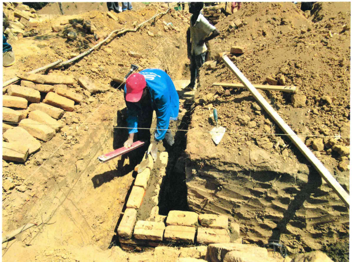
Die Handwerker bauen die Mauern des Fundaments auf
