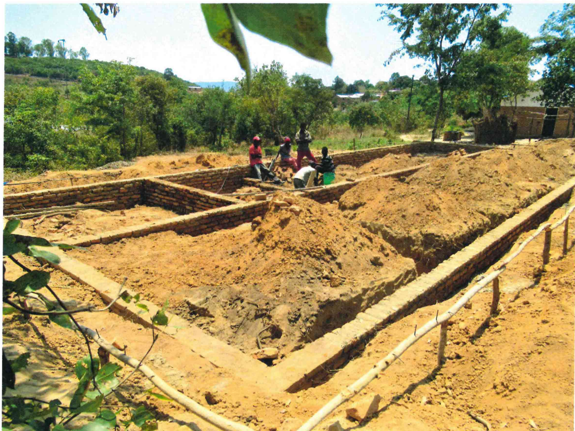
Die Mauern des Fundaments sind fast fertig
