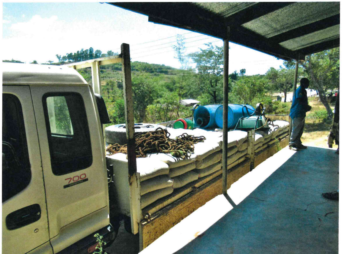
Das Baumaterial wird geliefert
