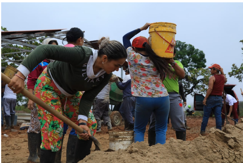
Frauen haben eine führende Rolle beim Aufbau von Kapazitäten und beim Bau der Ecomun-Wohngenossenschaften übernommen. © ECOMUN
