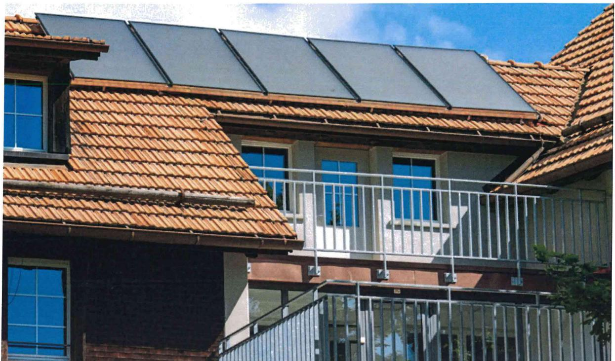
**SOLARPANELE FÜR DIE WARMWASSERAUFBEREITUNG**
