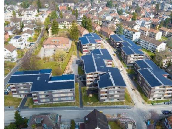
Vollflächige Solardächer in der Siedlung Balberstrasse 2
