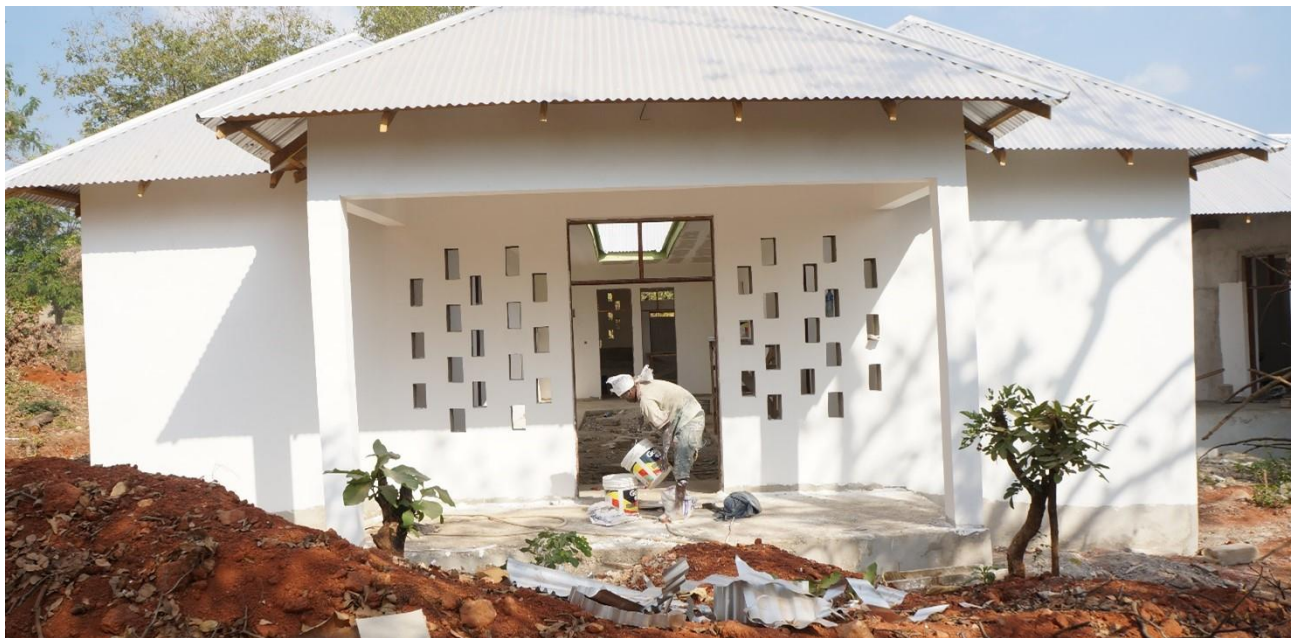
Der Haupteingang des Gebäudes wird gestrichen.
