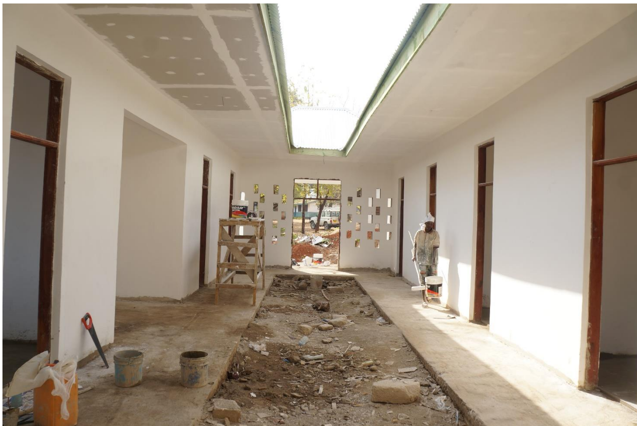
Im Innern des Gebäudes befinden sich auf der linken und rechten Seite Zimmer für die schwangeren Frauen. Der linke (breite) Korridor führt zur Küche.
