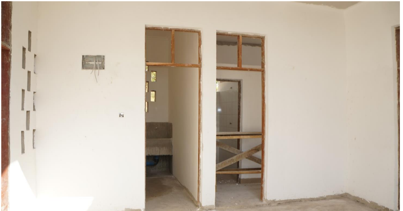
Zwei Türen im Wartezimmer des Gebäudes – die linke Türe führt in die Waschküche und die Rechte zu den Toiletten.
