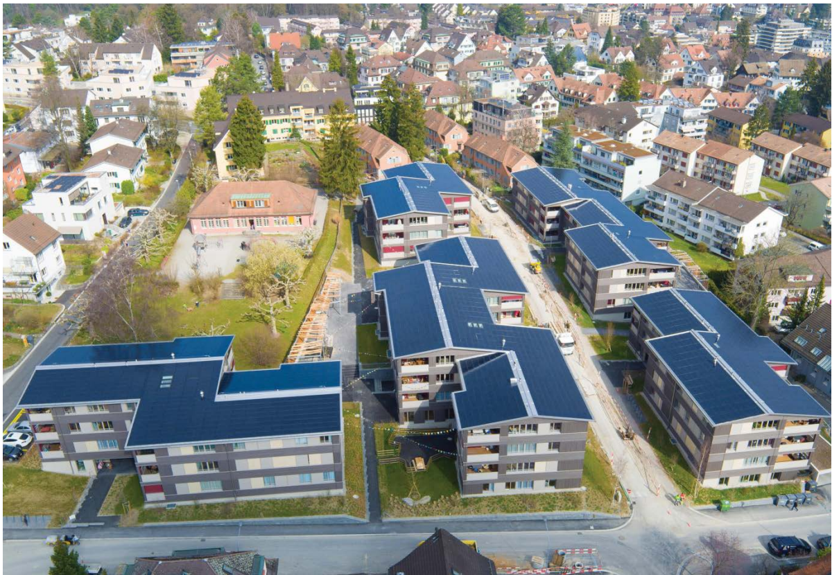
Photovoltaik-Anlage der ABZ-Siedlung Balberstrasse (Foto: SunTechnics Fabrisolar AG)
