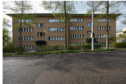
Zürich, Waidfussweg 35-37, Trottenstrasse 84-91 (Ref.-Nr. 13700) Marktwert: CHF 12'510'000
